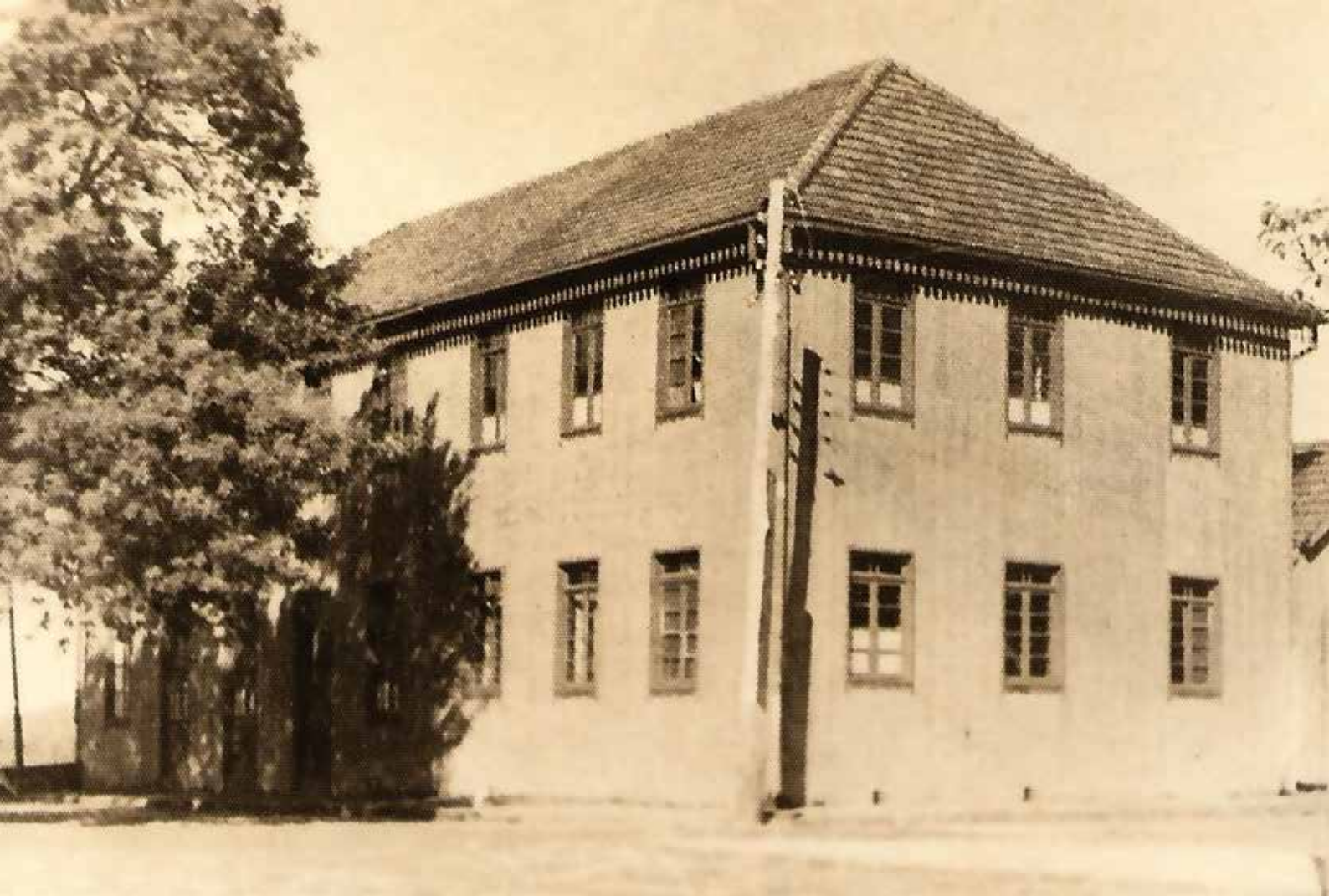
Hospital São Roque em 1955, antigo Hotel Boa Vista, centro de Carlos Barbosa
